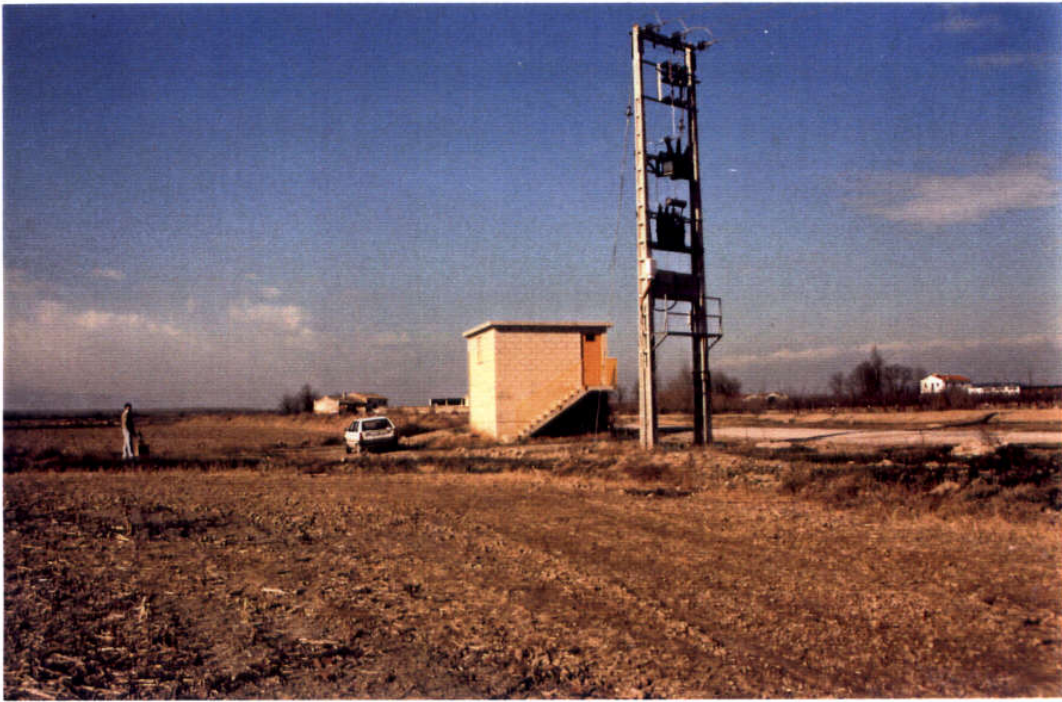
FOTO 1: Captación de aguas subterráneas.
