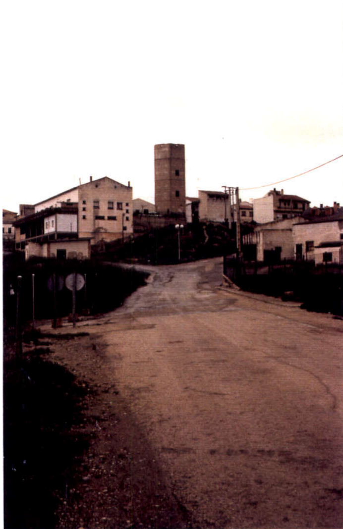
FOTO 2: Depósito regulador (centro de la foto).
